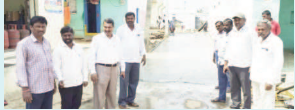
సీసీ రోడ్డు నిర్మాణ పనుల పరిశీలిస్తున్న ఎంపీటీసీ
